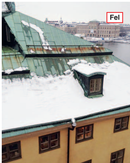
Bild 1 och 2: Avsmältning på varmt tak: Smältvattnet har frusit till is i spygatten. Högra bilden ger en antydning om den möjliga konsekvensen.
