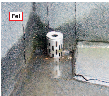
Bild 9: Exempel på hur brunn placeras alltför nära sarg: Det är i praktiken omöjligt att skapa en tillförlitlig anslutning mellan tätskiktet och brunnens fläns. Det måste finnas fritt utrymme minst 300 mm åt alla håll från brunnscentrum för att montaget ska kunna utföras.
