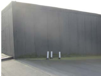
1. Här har tätskiktsmatta använts för att täcka både väggar och tak på ett helt fläktrum.
